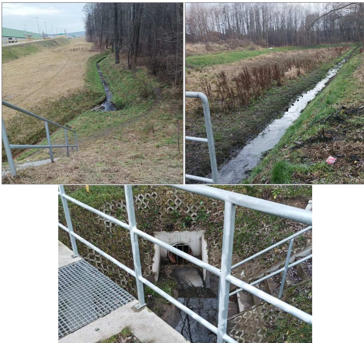
Zdjęcie 1a-c Ciek przepływający przez analizowany teren (widok z ul. H. Kołłątaja, na zbiornik retencyjny oraz wylot do kanalizacji deszczowej) Fot. Elżbieta Drożdżał (20.01.2023 r.)
