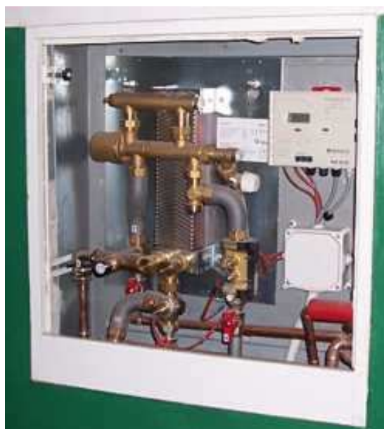
Rys. 15. Stacja mieszkaniowa c.w.u.
