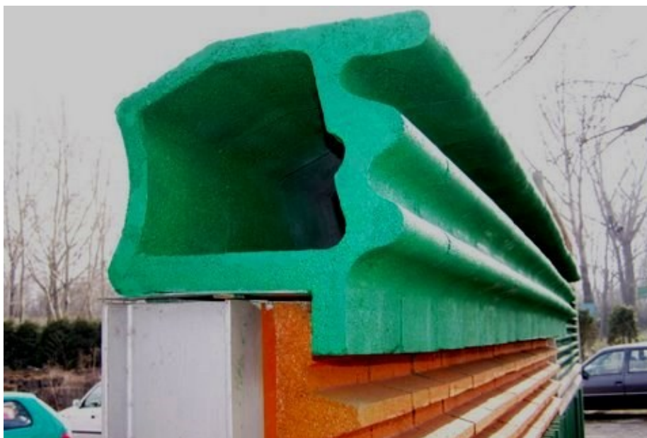
Rysunek 3–16. Dyfraktor zamontowany na krawędzi górnej ekranu akustycznego [36]
