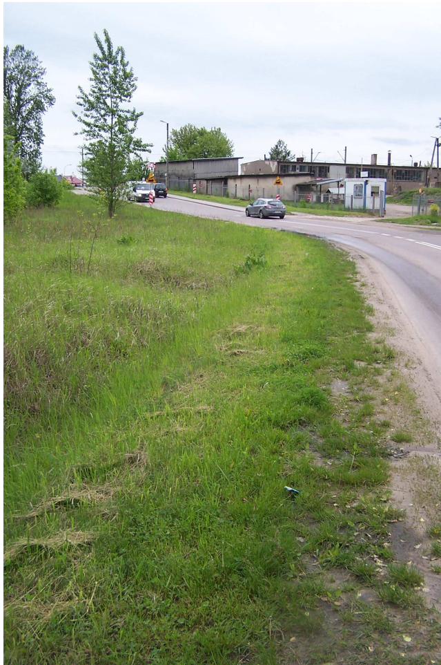
Ul. Klepacka między przejazdami kolejowymi w rejonie projektowanych ulic Klepacka2 i Klepacka 4
