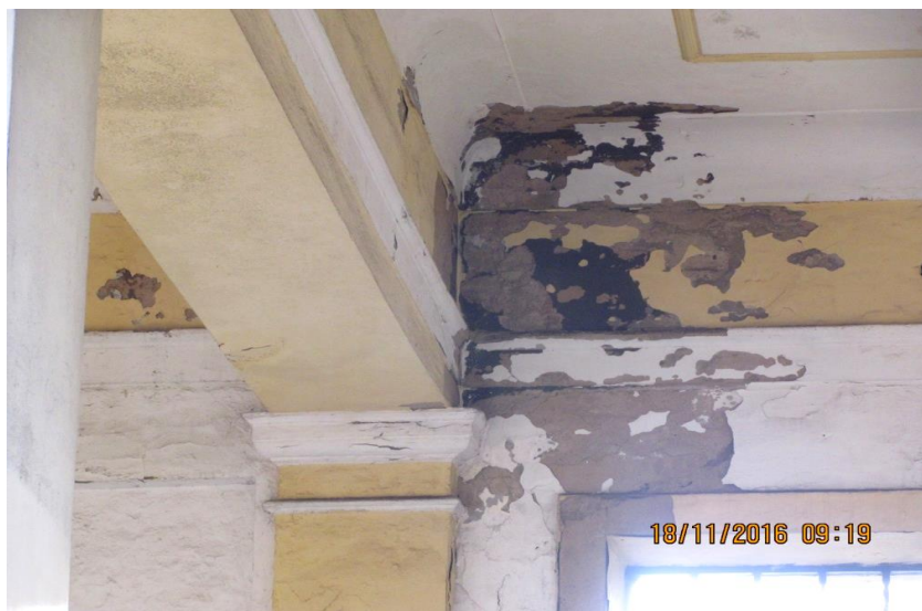
Fot.17 Uszkodzenie wewnątrz Pawilonu-widoczny intensywny rozwój glonów i pleśni .Poziom zawilgocenia – z braku odpływu wody . Nieprawidłowo wykonane tzw. „zerwanie wody” i połączeń obróbek blacharskich attyki z dachem jednospadowym
