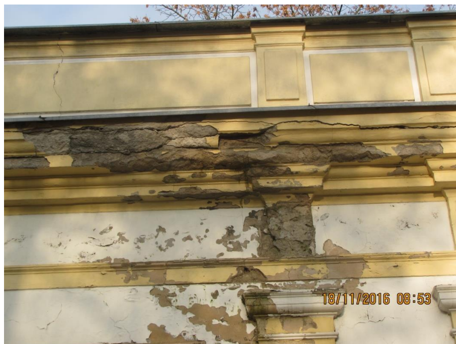
Fot.15 Uszkodzona konstrukcja gzymsu oraz tynki Pawilonu
