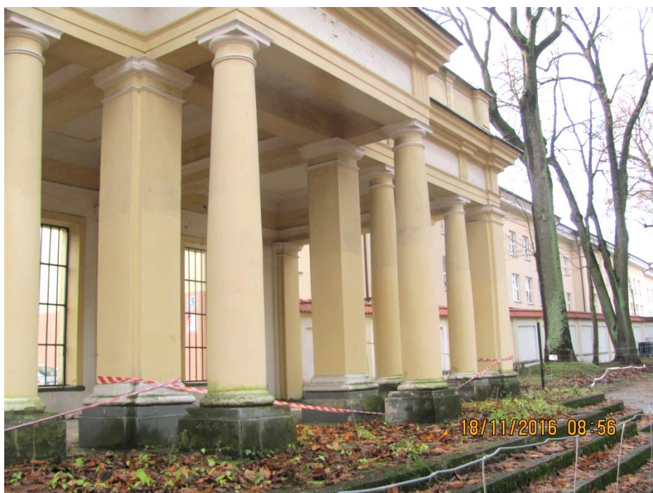
Fot.10 Pawilon Włoski -widoczna korozja biologiczna schodów i fundamentów (podstaw) kolumn
