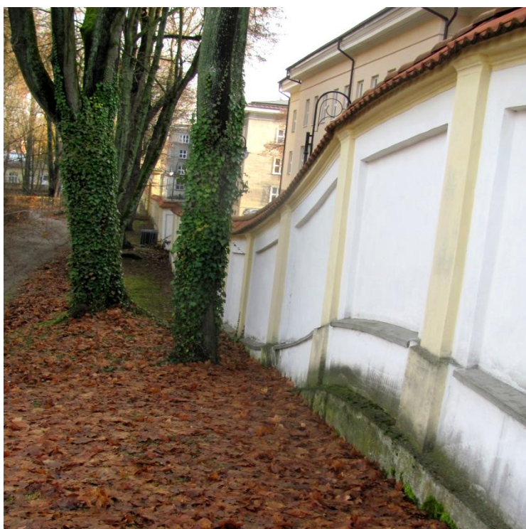
Fot.6 Destabilizacja fundamentów przez korzenie drzew rosnących w pobliżu .Mur odchyła się od pionu.
