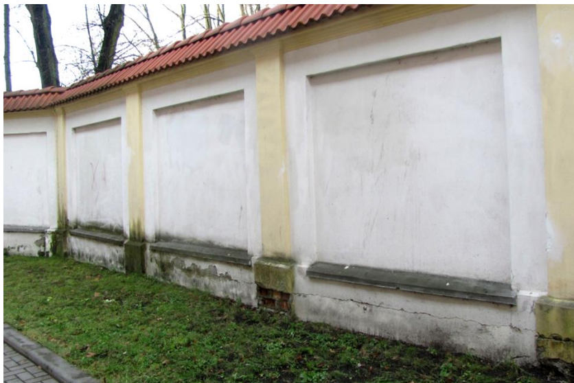
Fot.3 Fragment muru od strony akademików –widoczna pozioma bruzda (pęknięcie) na styku fundamentu i muru. Na okapnikach betonowych -intensywny rozwój mchów i glonów
