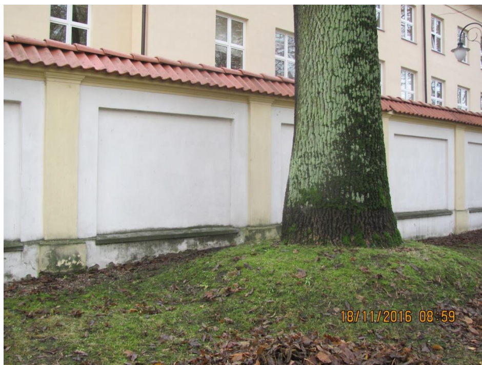
Fot.5 Rosnące w pobliżu muru drzewo z wysoko uniesioną rzędną terenu powoduje podciąganie kapilarne z gruntu i intensywny rozwój mchów i glonów ( algae )
