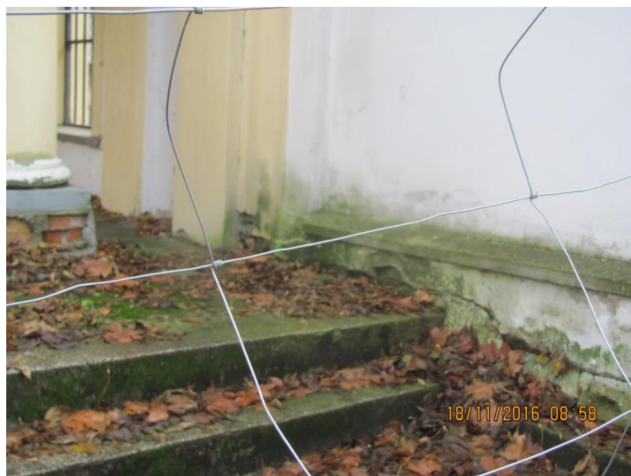
Fot.13 Zrzut wód opadowych bezpośrednio pod fundament Elewacja od strony akademików . Liczne sole węglanowe.
