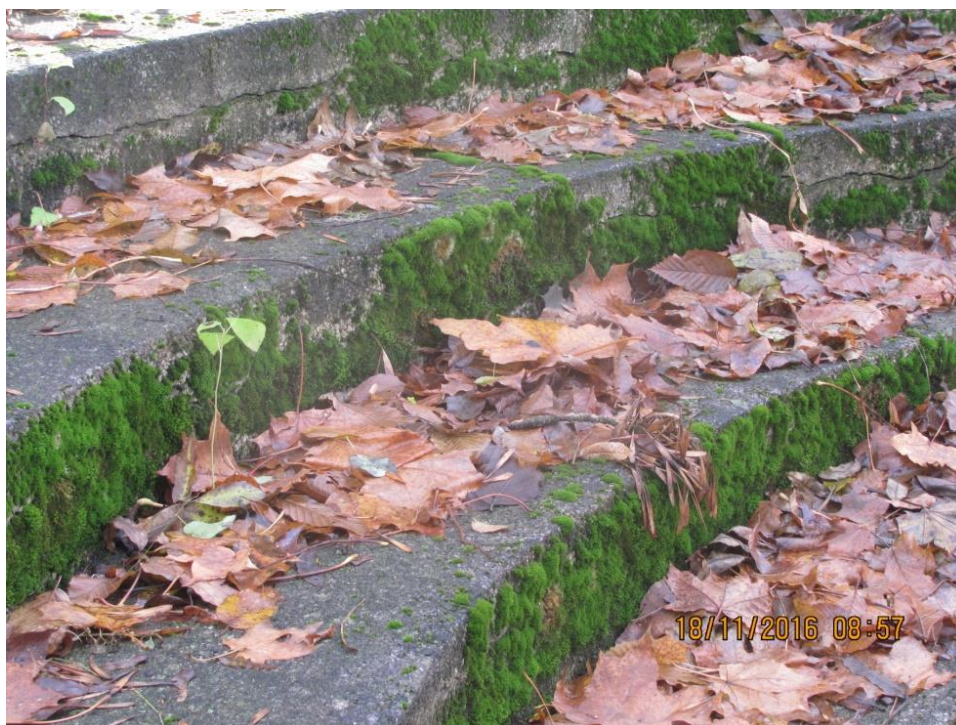
Fot.12 Uszkodzone wykładziny schodów z lastyko przez mchy i glony
