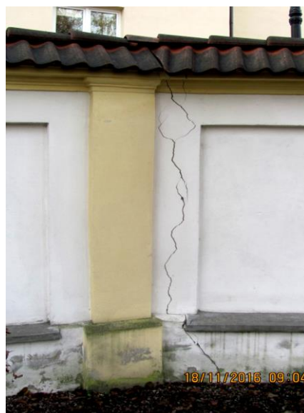
Fot. 4 Widok od strony ciągu pieszego przy akademiku –pęknięcie muru „przestrzałowe” widoczne również od strony ogrodu
