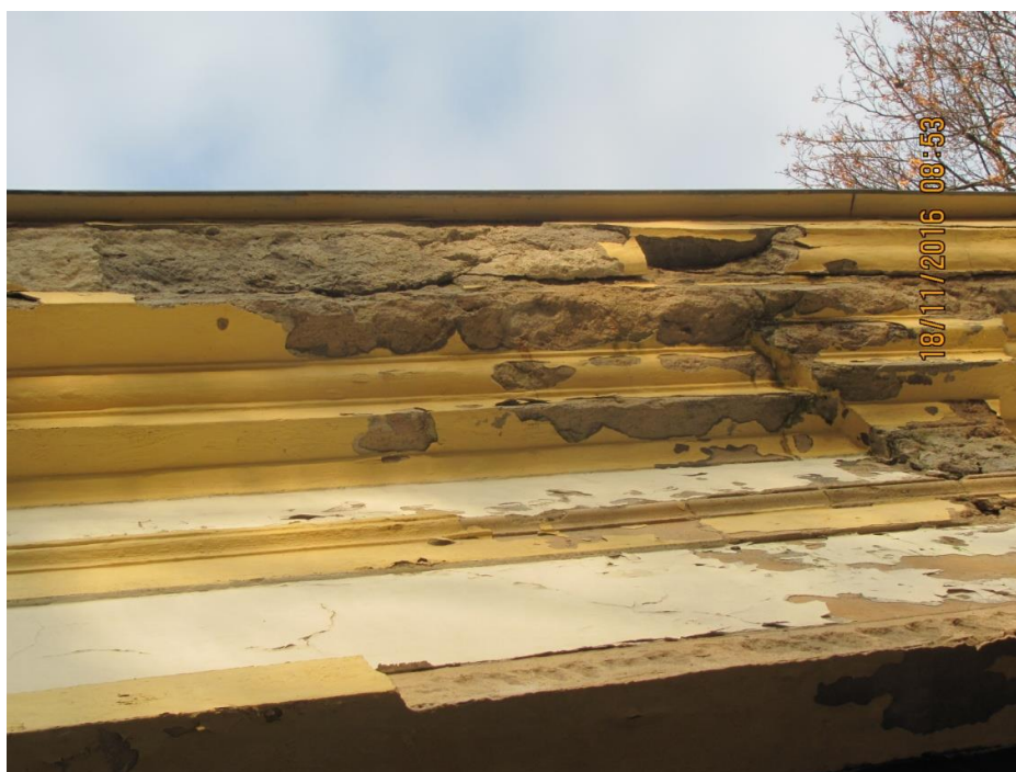
Fot. 16 Widoczna destrukcja tynków gzymsu pod balustradą daszki Pawilonu Włoskiego uszkodzonych przez przemarzanie, sole i glony ( algae ) . Rynna pogrążona o zbyt małym przekroju nie zapewnia prawidłowego odprowadzenia wód deszczowych
