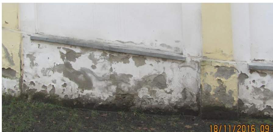
Fot.19 Uszkodzone tynki cokołów muru ogrodzenia
