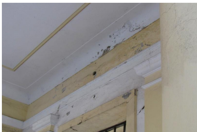
Fot. 18 Na tynkach- Grzyb rozkładu pleśniowego ( Aspergillus Niger )
