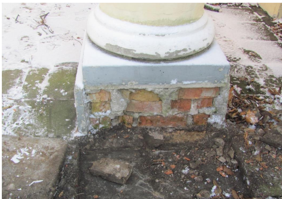
Fot.11 Odkrywka fundamentu pod kolumną –zniszczona cegła
