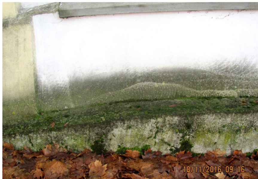
Fot. 7 Intensywny rozwój glonów ( algae ) oraz mchów i porostów na murze w wyniku podciągania z gruntu wilgoci
