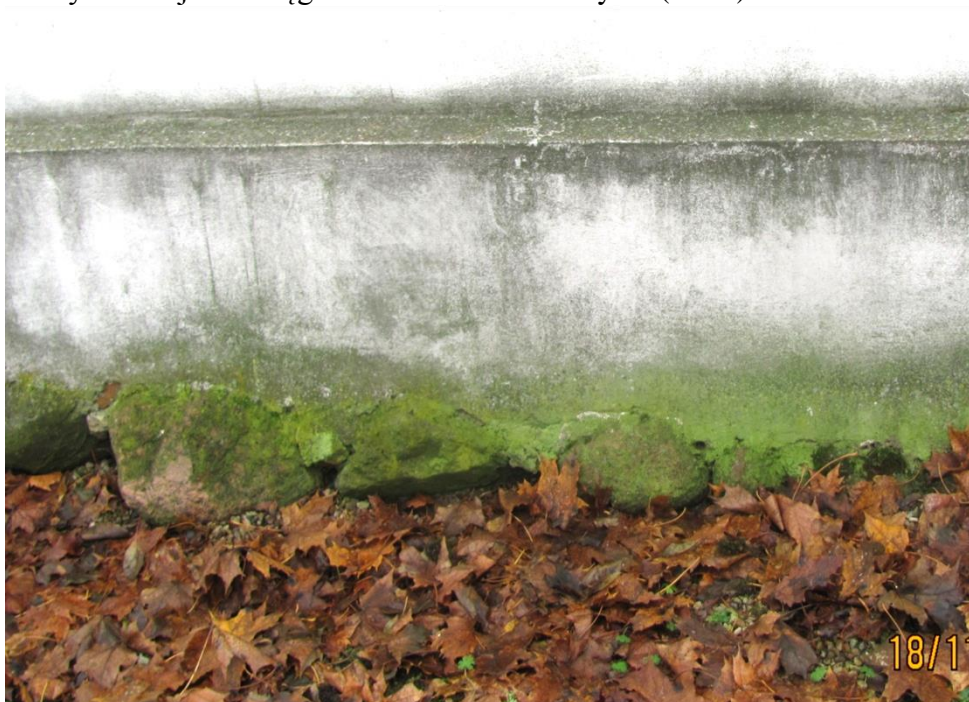
Fot.2 Fundament z kamienia polnego –fragment muru od strony ciągu pieszego wzdłuż budynku akademika
