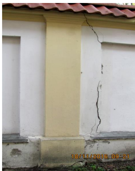
Fot. 4 Widok od strony ciągu pieszego przy akademiku –pęknięcie muru „przestrzałowe” widoczne również od strony ogrodu
