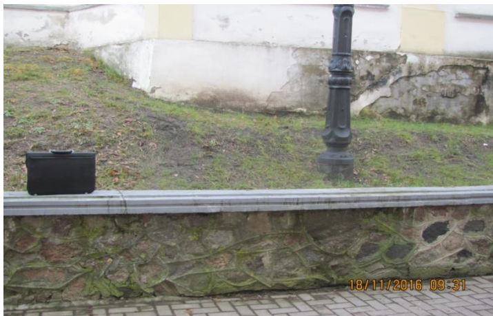
Fot. 20 Murek oporowy zabezpieczający skarpe przed osunięciem gruntu na ciąg pieszy
