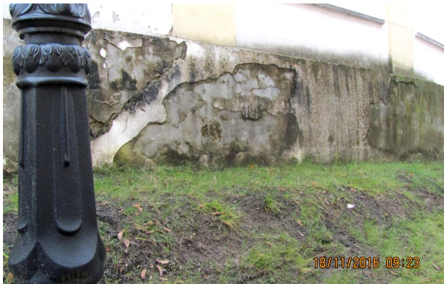
Fot.9 Całkowite uszkodzenie tynków muru od strony akademików
