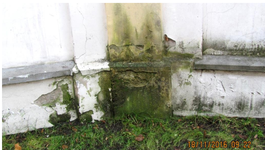
Fot.8 Uszkodzenie tynku przez sole i korozję biologiczną
