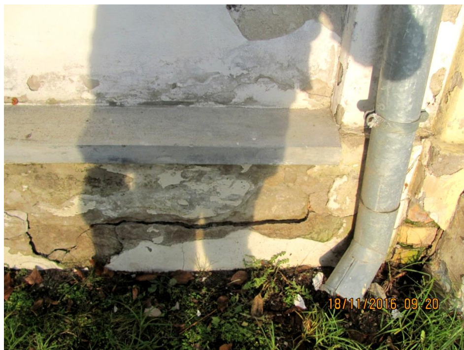
Fot.13 Zrzut wód opadowych bezpośrednio pod fundament Elewacja od strony akademików . Liczne sole węglanowe.
