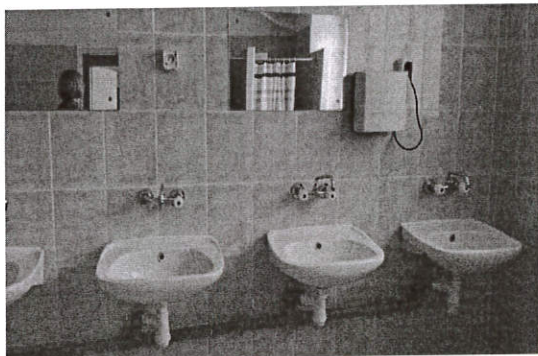
Fot Nr 3 - istniejące łazienki
