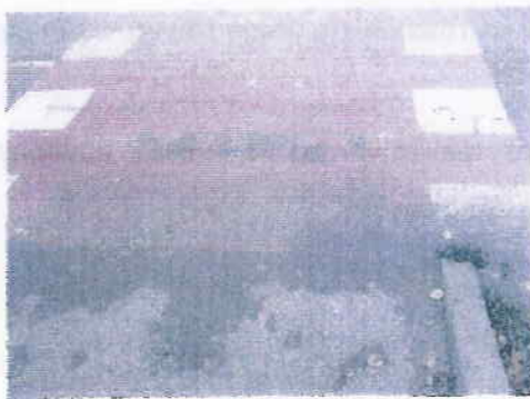
Zdjęcie 2 Bezszwowe łączenie nawierzchni DDR z jezdnią w miejscu przejazdu rowerowego (fot. Rowerowy Białystok)
